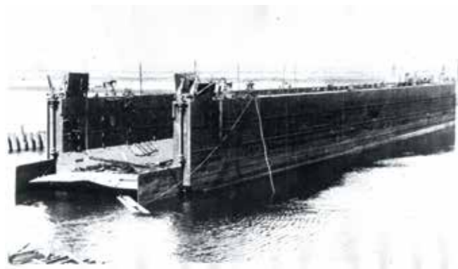
Плавучий док проекта 28 для транспортировки подводных лодок типа «Щ» и типа «С». 1938 год
