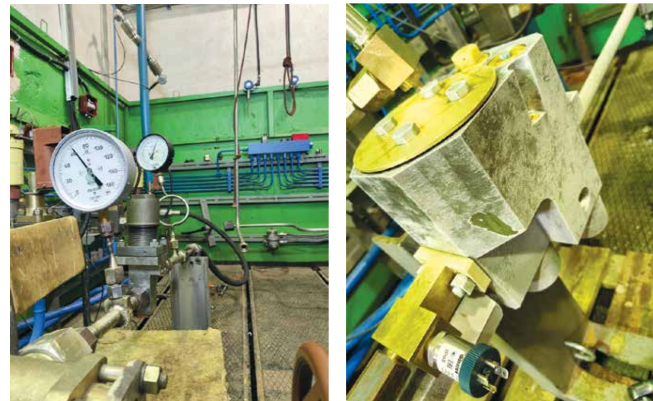
Рисунок 6. Редукционные клапаны в процессе испытаний
