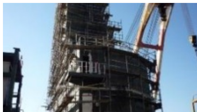
Рис. 6. Транспортировка секций, формирование надстройки
