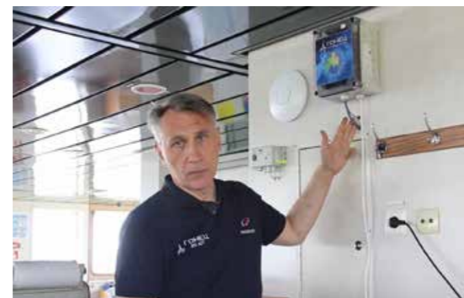
Установка судовых земных станций «Гонец» на судно
